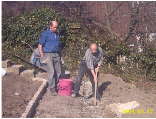
Wege und Beete werden neu angelegt
